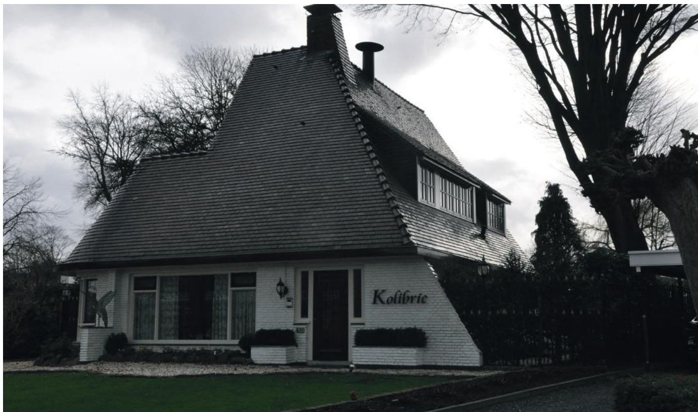
Villa Kolibrie aan de Bredaseweg 418, een ontwerp van de bekende Tilburgse architect Sjef Donders.
