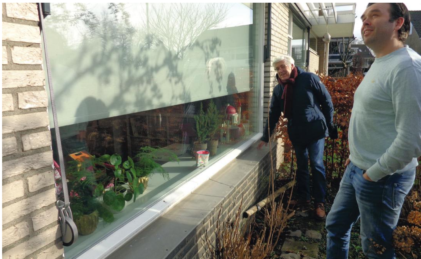
Joost van Dun (rechts) kijkt met energie-adviseur Marc Vintges de ruiten in de voorgevel.
