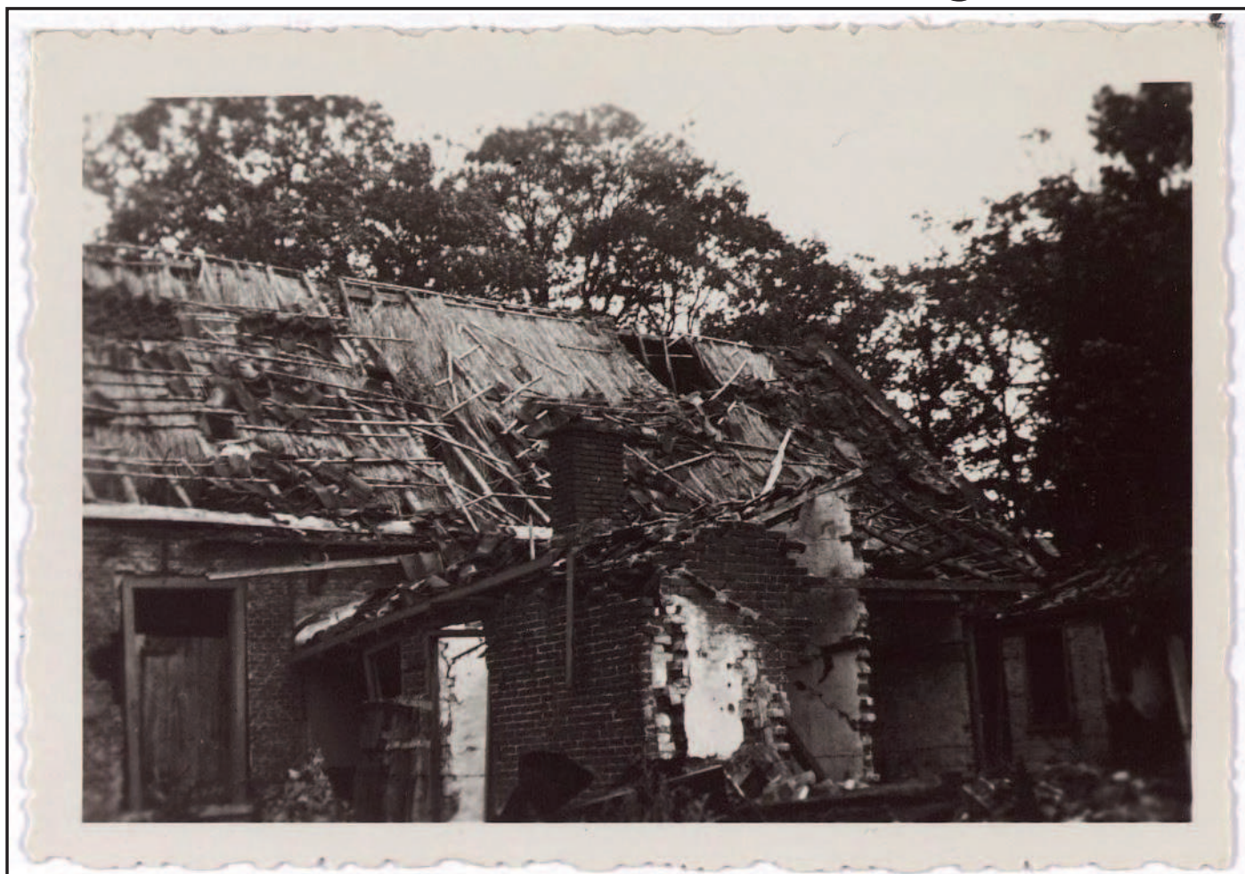
Zwaar beschadigd huis aan de toenmalige Schaapstraat, nu de Vierwindenlaan, na Duitse bombardementen op 10 en 11 mei 1940. Foto: Regionaal Archief Tilburg
